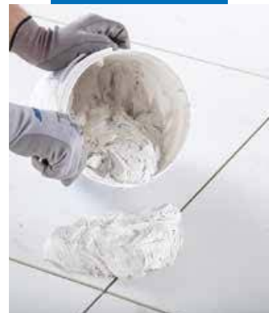
Получаване на кремообразна хомогенна смес
