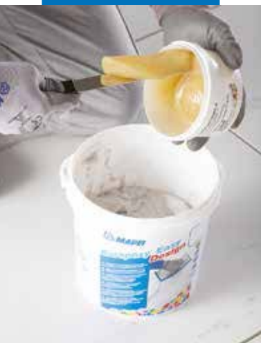
Изсипете втвърдителя (компонент Б) в съда с компонент А
