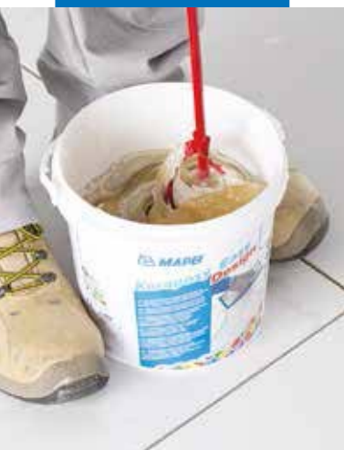
Смесване на компонентите (А+В)
