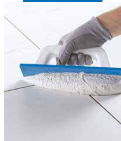
Разстилане на Kerapoxy Easy Design с маламашка Mapei
